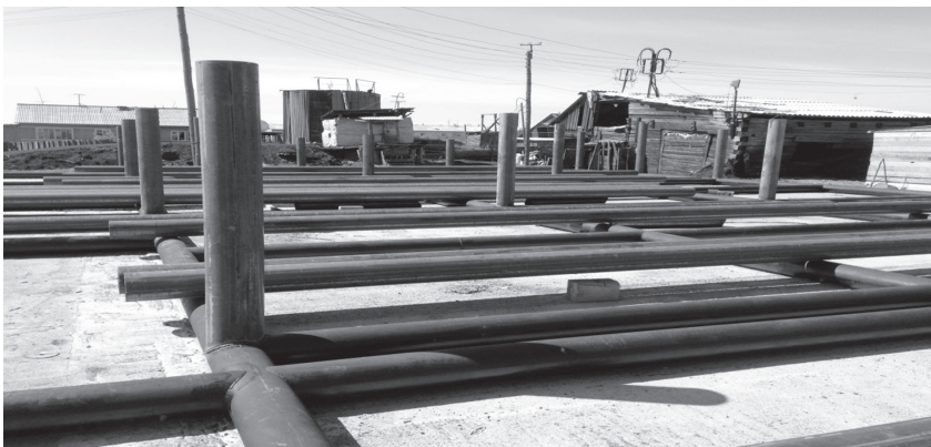
Рис. 9. Возведение нулевого цикла модульной котельной усановки (МКУ) в с. Крест-Хальджай Томпонского улуса
